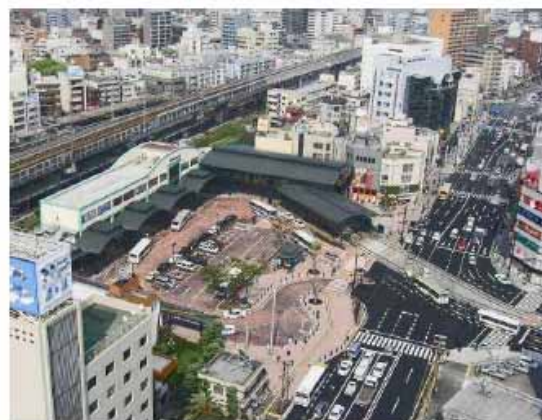
写真2 横川エリア改善後 (平成16年3月 広島国道事務所撮影)
