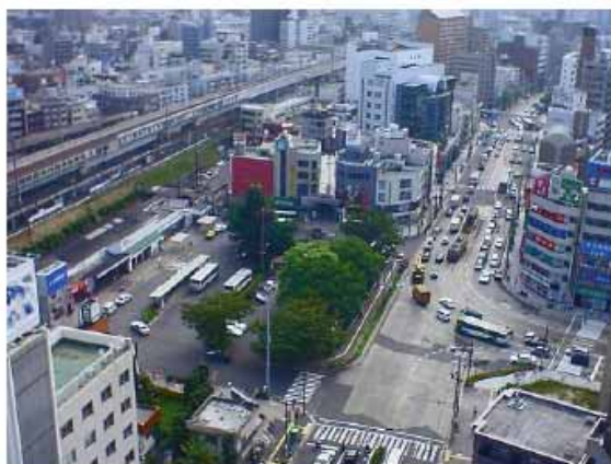
写真1 横川駅前改善前 (平成14年8月 広島国道事務所撮影)
