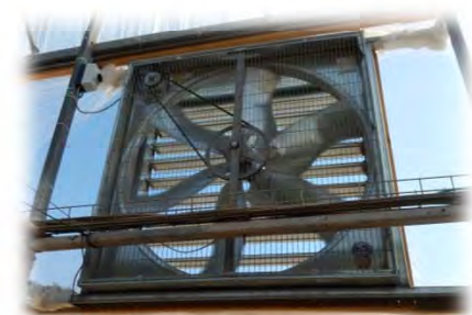
パッド&ファン冷却システム(左:パッド、右:ファン)
