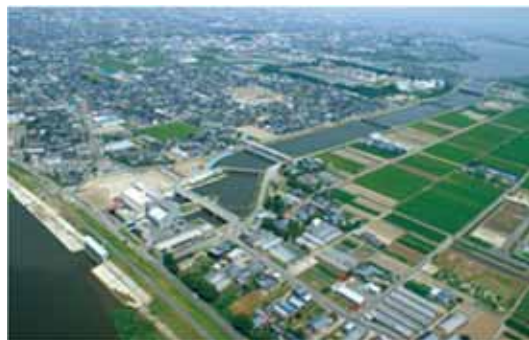
【図表1】昭和23年に栗ノ木排水機場が運転を開始。当時東洋一の排水能力で亀田郷を乾田に導いた。その後、昭和43年に親松排水機場が完成して、栗ノ木排水機場に代わって排水の基幹施設となり、現在では、新親松排水機場（左：平成20年完成）が、その役割を担っている。 新潟平野は、当該排水機場を含む4機場で、信濃川平均流量に相当する毎秒450立米の水を強制排水することで維持されている。
