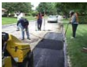
図2-1 道路改修作業
