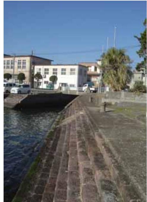
図3 - 5 折口町周辺港湾施設
