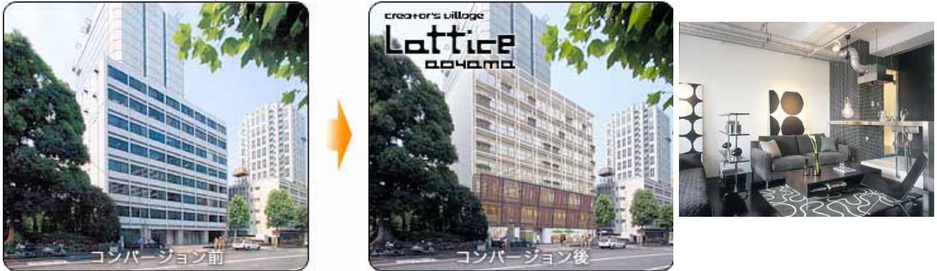
日本土地建物「ラティス青山」(建築1965年、改修工事2004年、地下2F地上8F)
