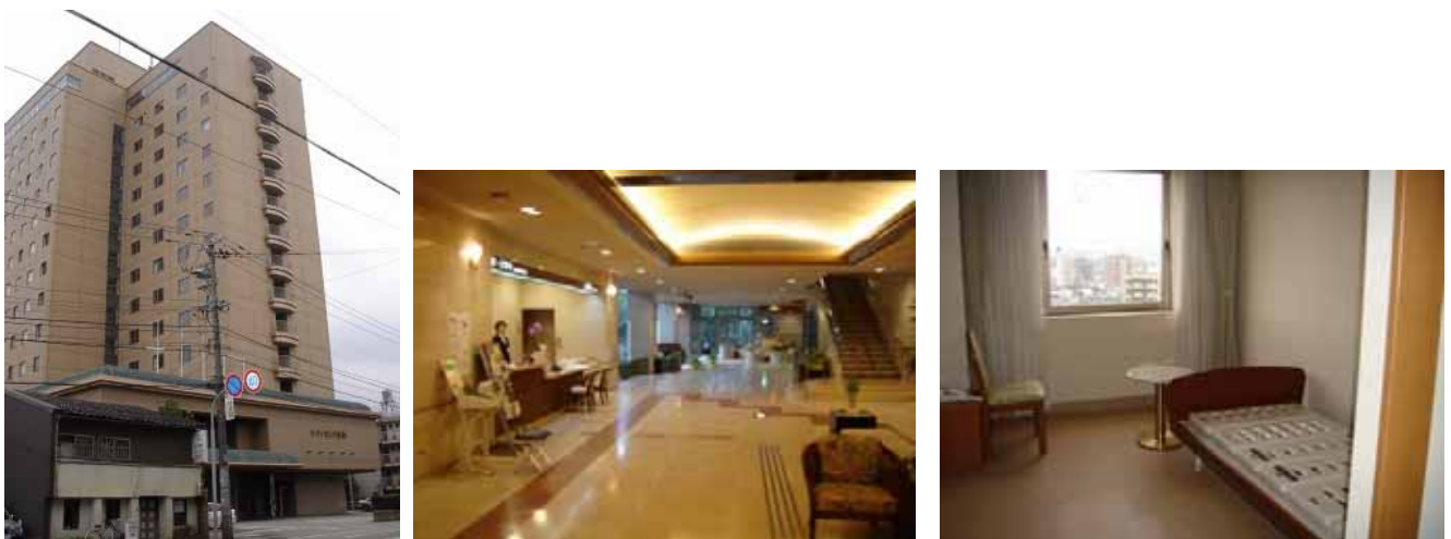
シティモンド金沢(建設1990年、改修2004年、地下1F地上14F)
