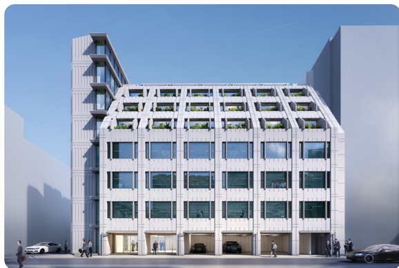
ゼノベプロジェクト第一弾：「日建ビル1号館」
