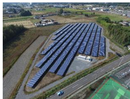
ハル水戸太陽光発電所
