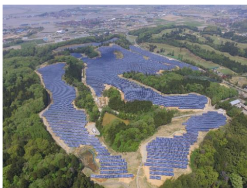
小松太陽光発電所
