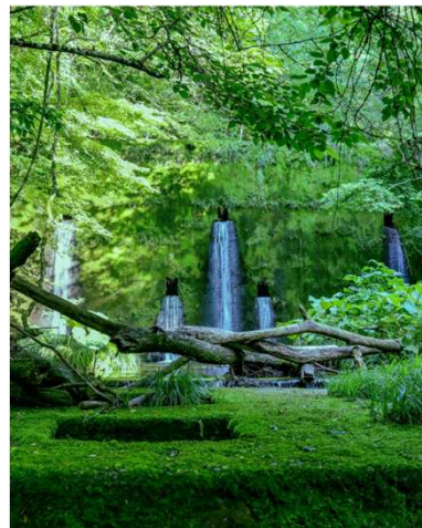
momo2007_2022様 秋田県 金山砂防ダム
