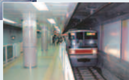
地下化による立体交差化後
