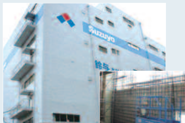
鈴与の物流施設の耐震補強工事
