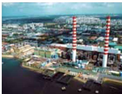
Senoko Energyの発電所
