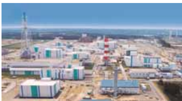
再処理施設全景
