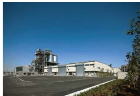
バイオマス発電施設
