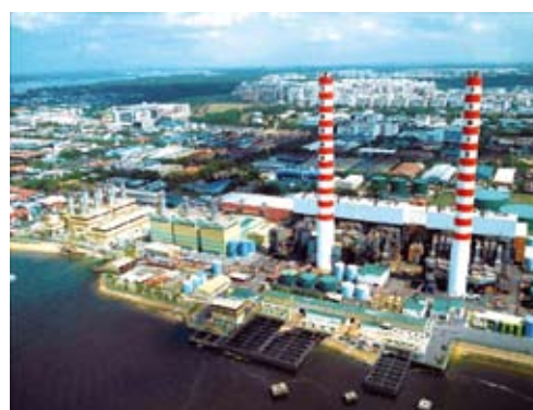
Senoko Energyの発電所
