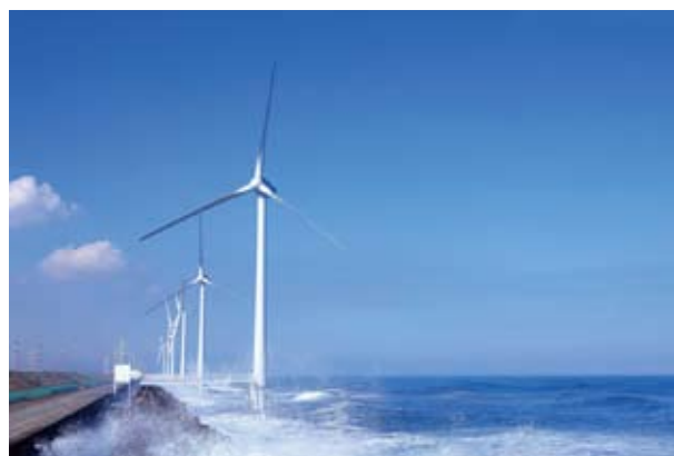
日本初の本格的洋上風力発電所「ウィンド・パワーかみす」
