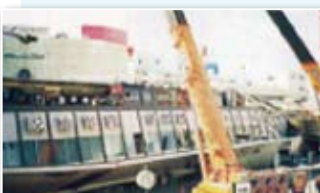
阪急電鉄(株)： 震災復旧工事(兵庫県) 震災により破壊された交通インフラ の復旧工事
