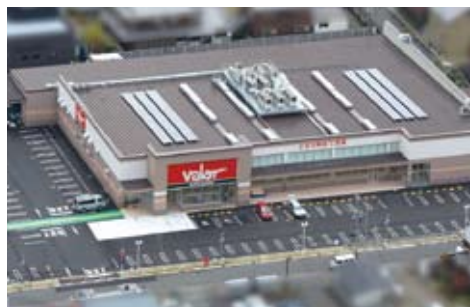
バロー彦根店のコジェネレーションシステムおよび太陽光パネル
