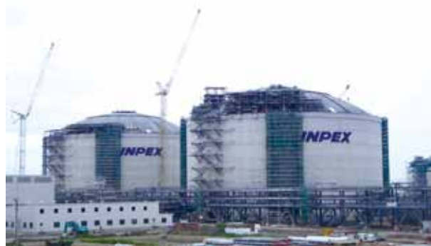
建設中の直江津LNG受入基地
