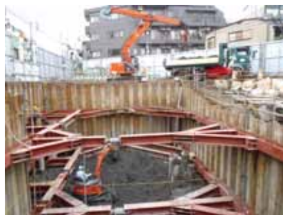
掘削工事現場
