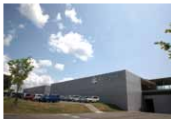
本社および工場外観
