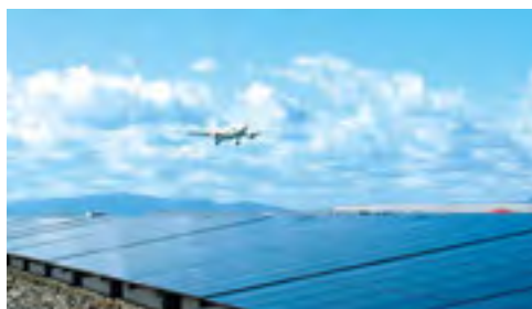
関西国際空港発電所
