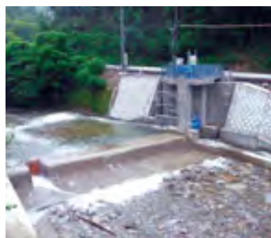
建設中の船間発電所
