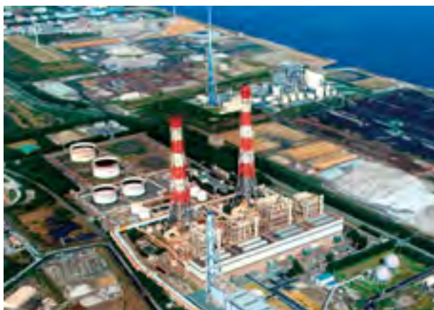
鹿島共同火力の発電設備全景
