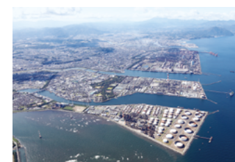
大分港湾岸(国土交通省九州地方整備局 別府港湾・空港整備事務所)
