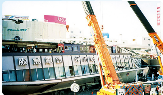
阪急電鉄(株)：震災復旧事業 阪神・淡路大震災により破壊された交通インフラの復旧を支援
