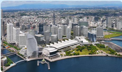
(株)横浜国際平和会議場：パシフィコ横浜 ホテル、オフィス、国際会議場などを備えた新都心「みなとみらい21」の建設
