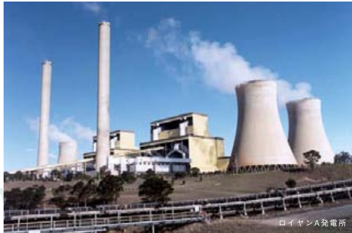
ロイヤンA発電所
