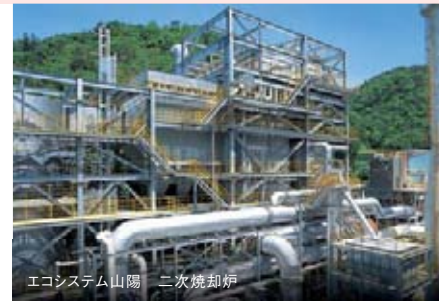
エコシステム山陽 二次焼却炉
