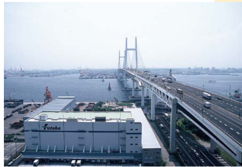
大黒第二冷凍物流センターは、平成17年、19,232トンの1号棟が完成し営業を開始。平成21年に収容能力24,744トンの2号棟が完成。多目的な利用が可能な大型解凍室と検品室、自然冷媒を利用した冷凍機を採用し、環境にも配慮した最新設備・構造を備え、顧客の多彩な要望に応えている。
