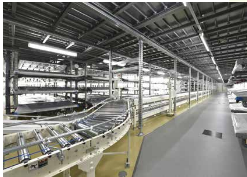
新設工場の様子
