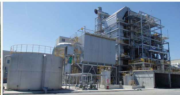
日向バイオマス発電施設全景
