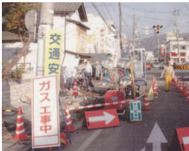
復旧工事の様子（北陸瓦斯（株））
