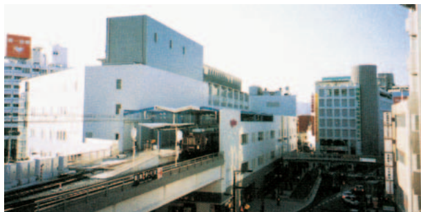
ターミナルビルの復旧(阪急電鉄(株))
