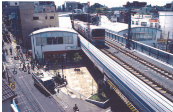
立体交差化後
