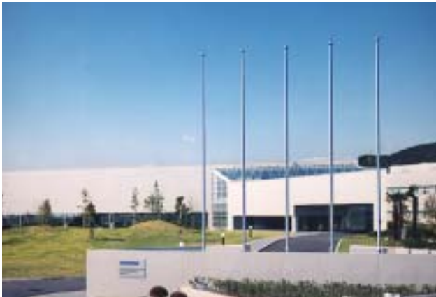
コーニングジャパン(株) (静岡県大須賀町) 液晶表示素子の研究・開発および製造のためのオペレーションセンターです。
