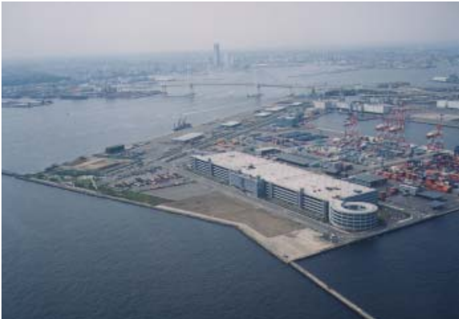
大規模・共同利用型総合物流施設（神奈川県横浜市） ～㈱横浜港国際流通センター～ 横浜港の3大埠頭のひとつである大黒埠頭に立地する、延床面積約32万㎡のわが国最大級の総合物流施設です。コンテナ化の進展や増加が予想される製品輸入に対応し、物流機能の高度化に寄与しています。
