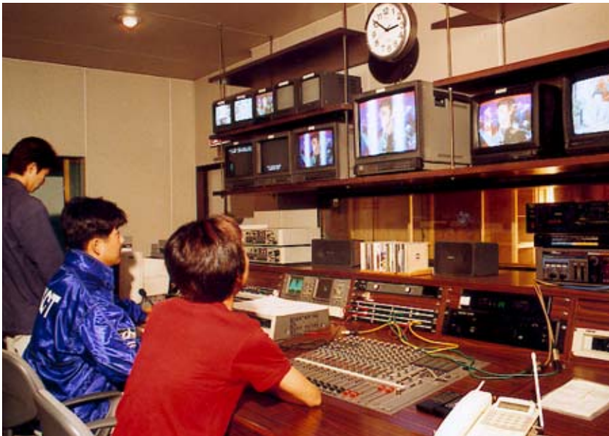
CATV放送センター(岡山県倉敷市) ～株式会社倉敷ケーブルテレビ～ 岡山県倉敷市、総社市、玉野市等を事業区域とするCATV事業者。地元情報番組(コミュニティチャンネル)を含めた多チャンネル放送サービスを提供するほか、各地方公共団体と協力し行政情報の広報にも貢献しています。 また、岡山県の情報ハイウェイ構想に対応してCATV回線を使ったインターネット接続サービスを行うなど、地域情報化の中核的なメディアとして期待されています。
