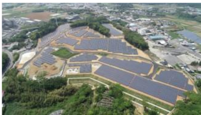
長崎県五島市の太陽光発電所
