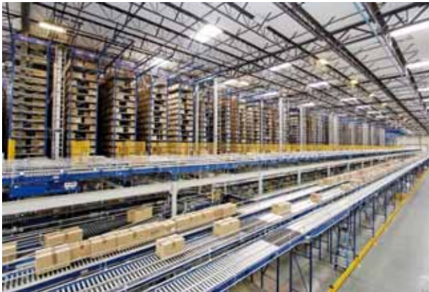
米国のシューズメーカーに納入した物流システム
