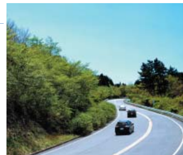
箱根ターンパイクは、日本でも有数の観光・リゾート地、箱根・伊豆の玄関口にあたる有料道路。小田原市、箱根町、湯河原町をまたぎ総延長15.8kmの区間の通行量は年間約100万台を数える。箱根へのアクセスに加え、伊豆方面へ向かう海岸沿いの一般道路の混雑渋滞を避ける迂回路としても利用されている。
