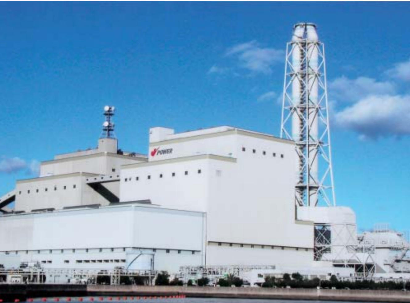
松浦火力発電所(長崎県松浦市志佐町)
