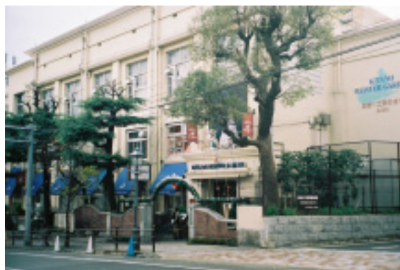
「北野工房のまち」全景
