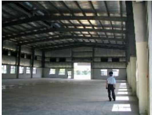
(写真上：見学した賃貸工場の内部)
