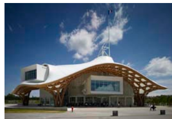
2010／ポンピドゥー・センター・メス (メス・フランス)
