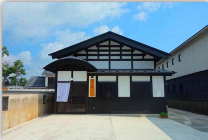
【改装後の外観】
