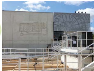
【石灰除去施設の外観】
