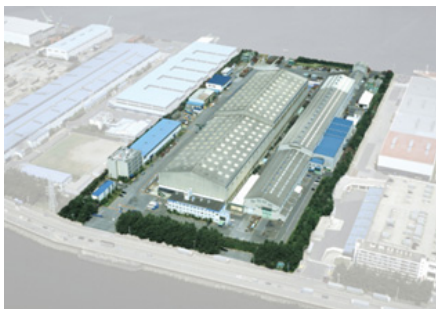
市川工場外観
