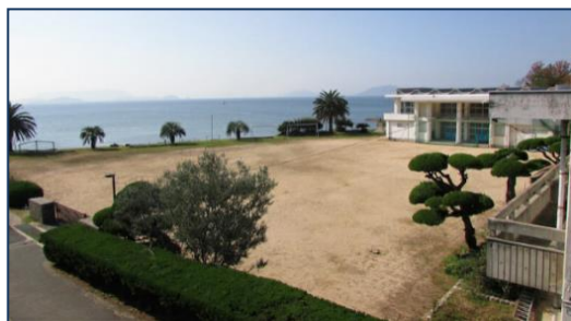
旧戸形小学校学校跡地の利活用 （土庄町）
