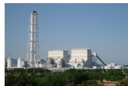
震災前の発電所全景
