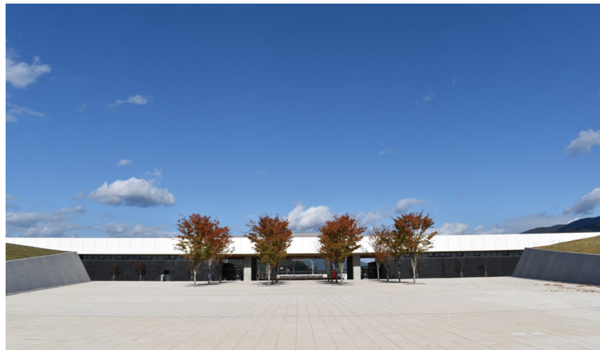
道の駅「高田松原」および東日本大震災津波伝承館(陸前高田市)
