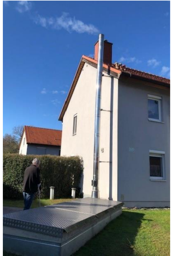
写真3-6 集合住宅と、集合住宅の地下に連結されるチップ保管庫
