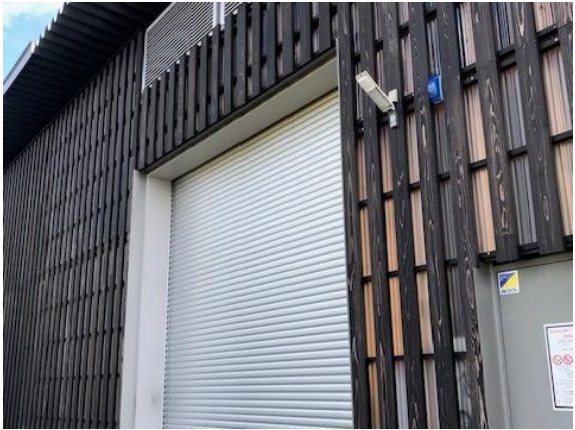
写真2-4 内子龍王バイオマス発電所壁面
