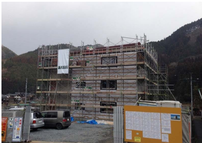
図表 2-13 市営 CLT 春日住宅（上図）／真庭木材事業協同組合 CLT 共同住宅（下図）
