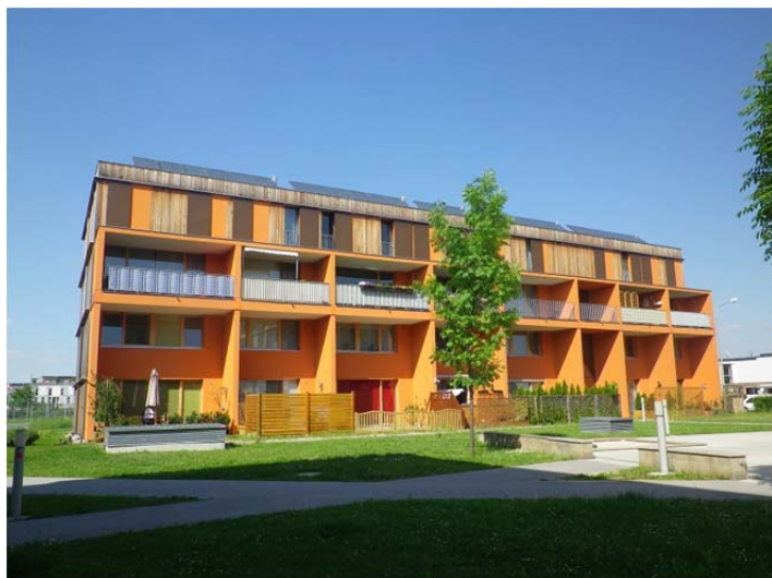
図表 2-5 オーストリアのウィーンにある CLT による集合住宅
