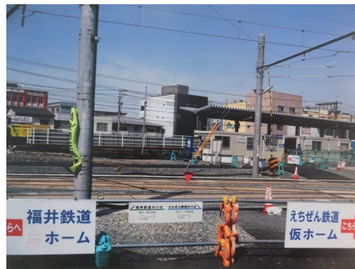
現在は線路接続のため工事中
