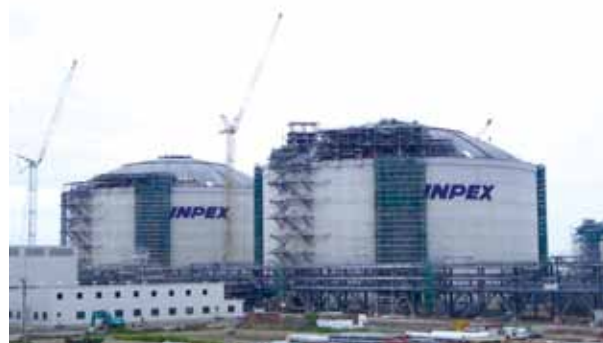
Naoetsu LNG acceptance base under construction
