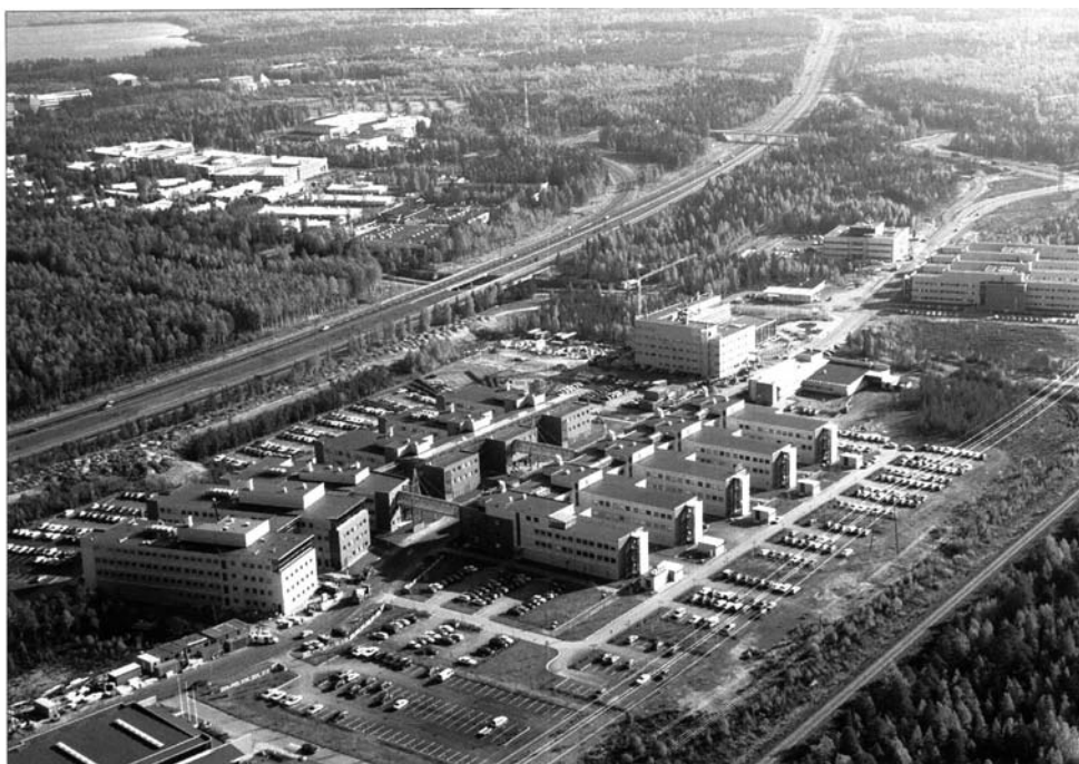
(テクノポリス フェーズⅡのテナントビル群)
