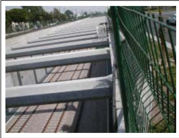
中工区トレンチ式
