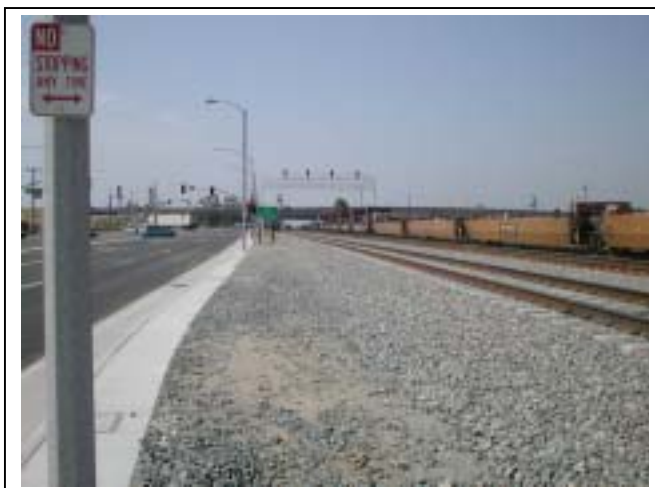
州道 9 1 号線との立体交差 - この先から地下に入る -
