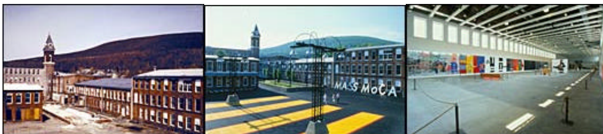
改築前の工場後
