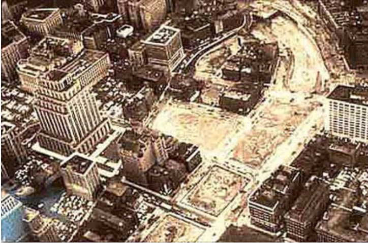
写真3. 旧高架高速道路建設工事
