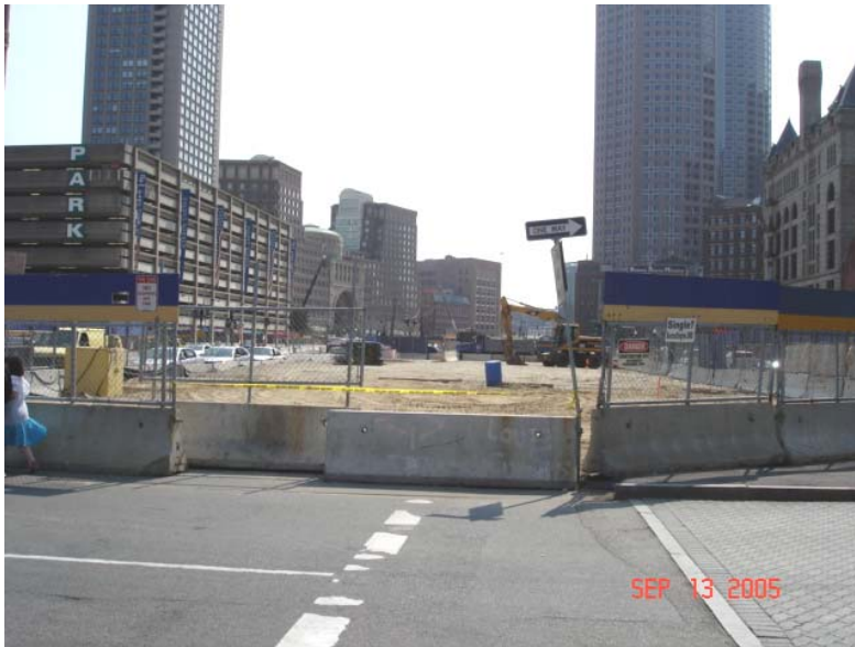
写真13. 旧高架道路の取壊しの後
