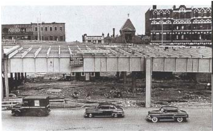
写真4. 旧高架高速道路の側面写真
