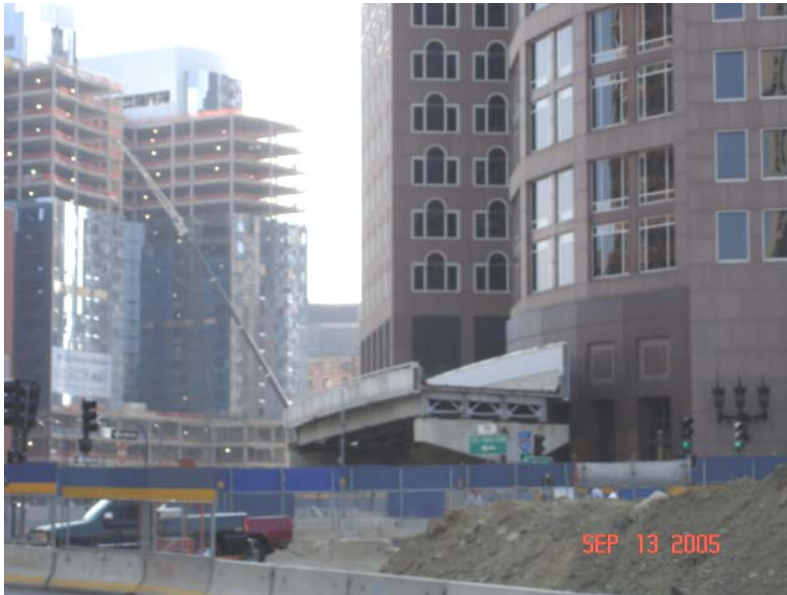
写真14. 残存する旧高架ランプ部分
