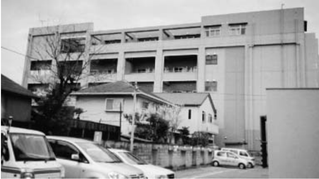
南側外観（外壁を取り壊してバルコニーを設置）
