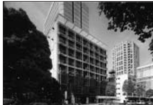
コンバージョン後の外観（都条例の規定により必要となる避難バルコニーを設置）
