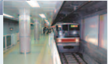
地下化による立体交差化後
