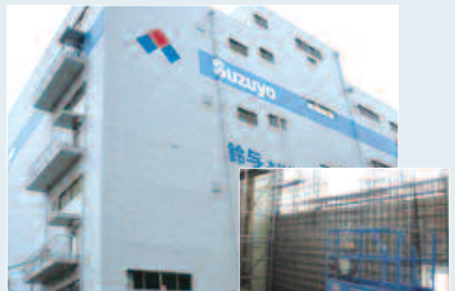
鈴与の物流施設の耐震補強工事
