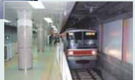
地下化による立体交差化後
