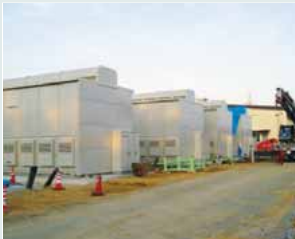
蓄電池による電力貯蔵システム
