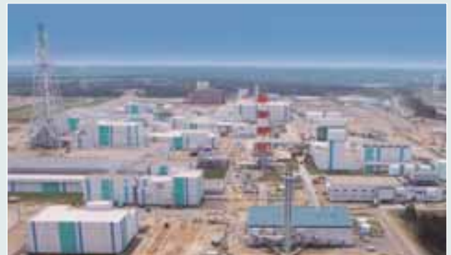
再処理施設全景
