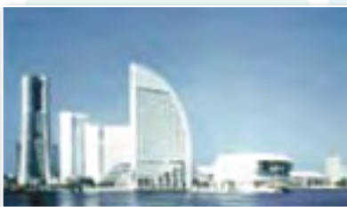
(株)横浜国際平和会議場： パシフィコ横浜(神奈川県) 横浜「みなとみらい21」地区における、ホテル、国際会議場などの建設・整備
