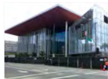
裁判所正面玄関(平成25年4月時点)
