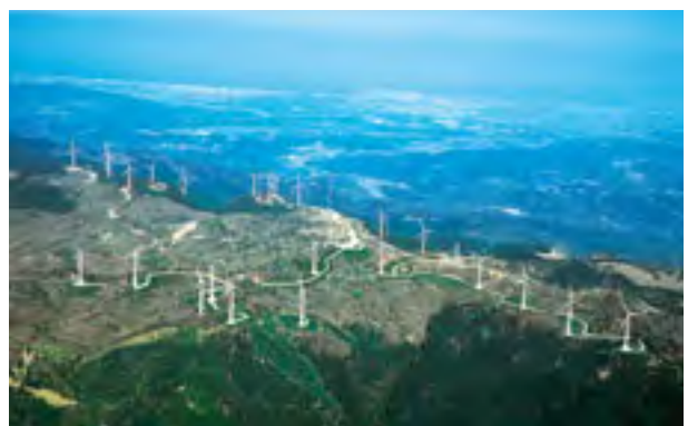
風力発電施設
