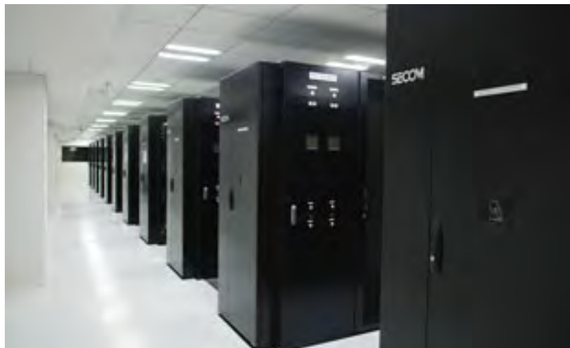
データセンター
