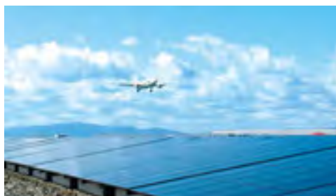
関西国際空港発電所
