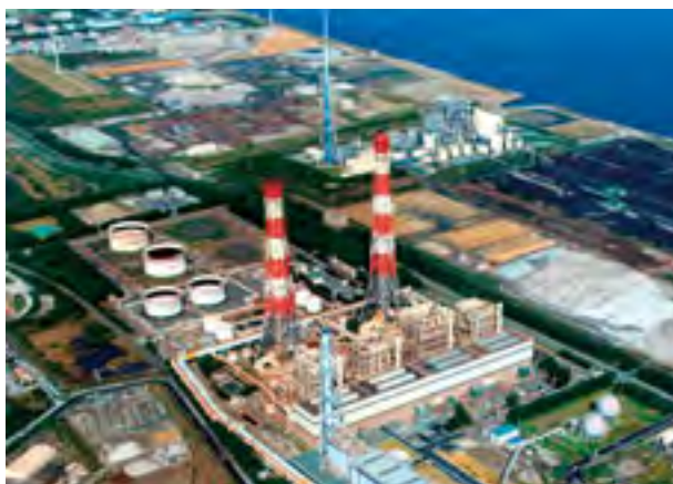
鹿島共同火力の発電設備全景
