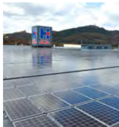
ホームセンター二戸店の太陽光発電設備
