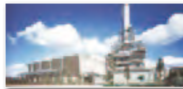
中山共同発電(株)： IPP発電事業(大阪府) 規制緩和にともなう鉄鋼メーカーの電力事業 進出を本邦初のプロジェクトファイナンスで支援
