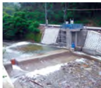
建設中の船間発電所
