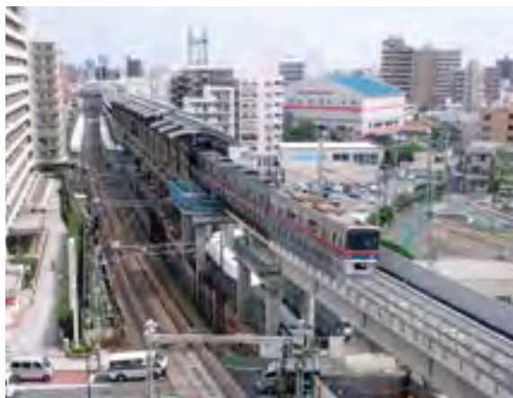
連続立体交差事業
