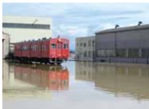
台風第18号等による被害を受けた線路
