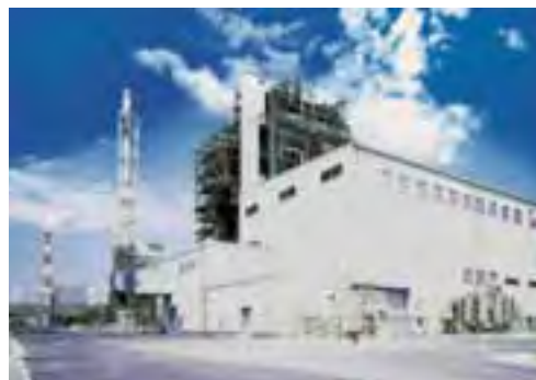
四日市霞発電所
