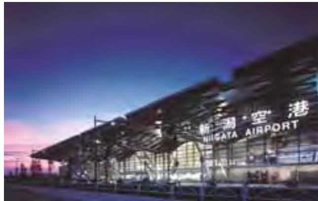
新潟空港ターミナルビル外観
