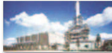
中山共同発電(株)： IPP発電事業(大阪府) 規制緩和にともなう鉄鋼メーカーの電力事業進出を本邦初のプロジェクトファイナンスで支援
