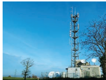
通信用タワー
