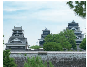
被災した熊本城(二の丸駐車場より)
