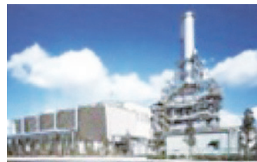
中山共同発電(株):IPP発電事業(大阪府) 規制緩和にともなう鉄鋼メーカーの電力事業進出 を本邦初のプロジェクトファイナンスで支援
