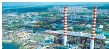
Senoko Power Ltd.(シンガポール) シンガポール最大の電力会社 Senoko Power に対し、劣後ファイナンスを実施
